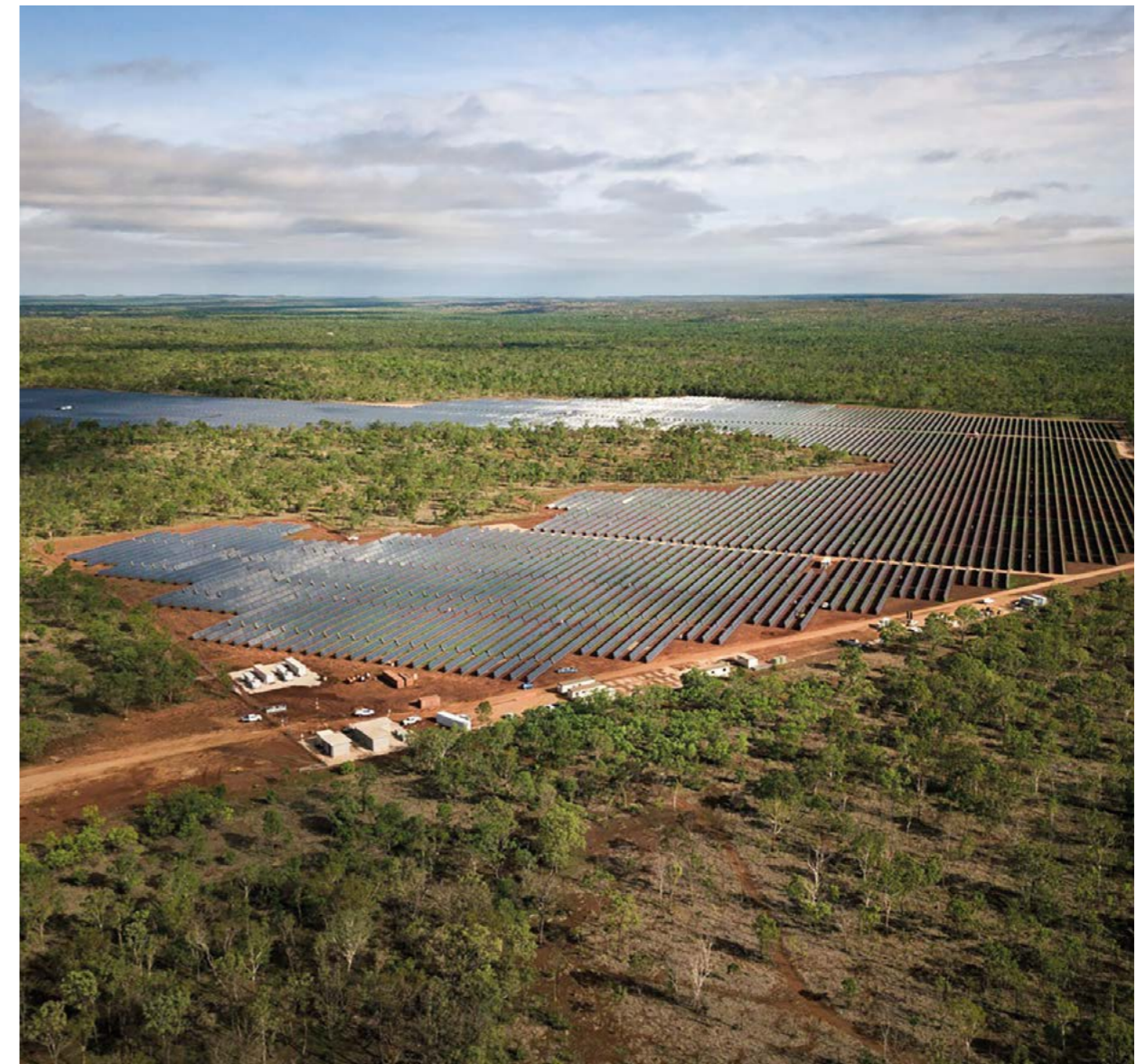
Impianto di Katherine - Australia
