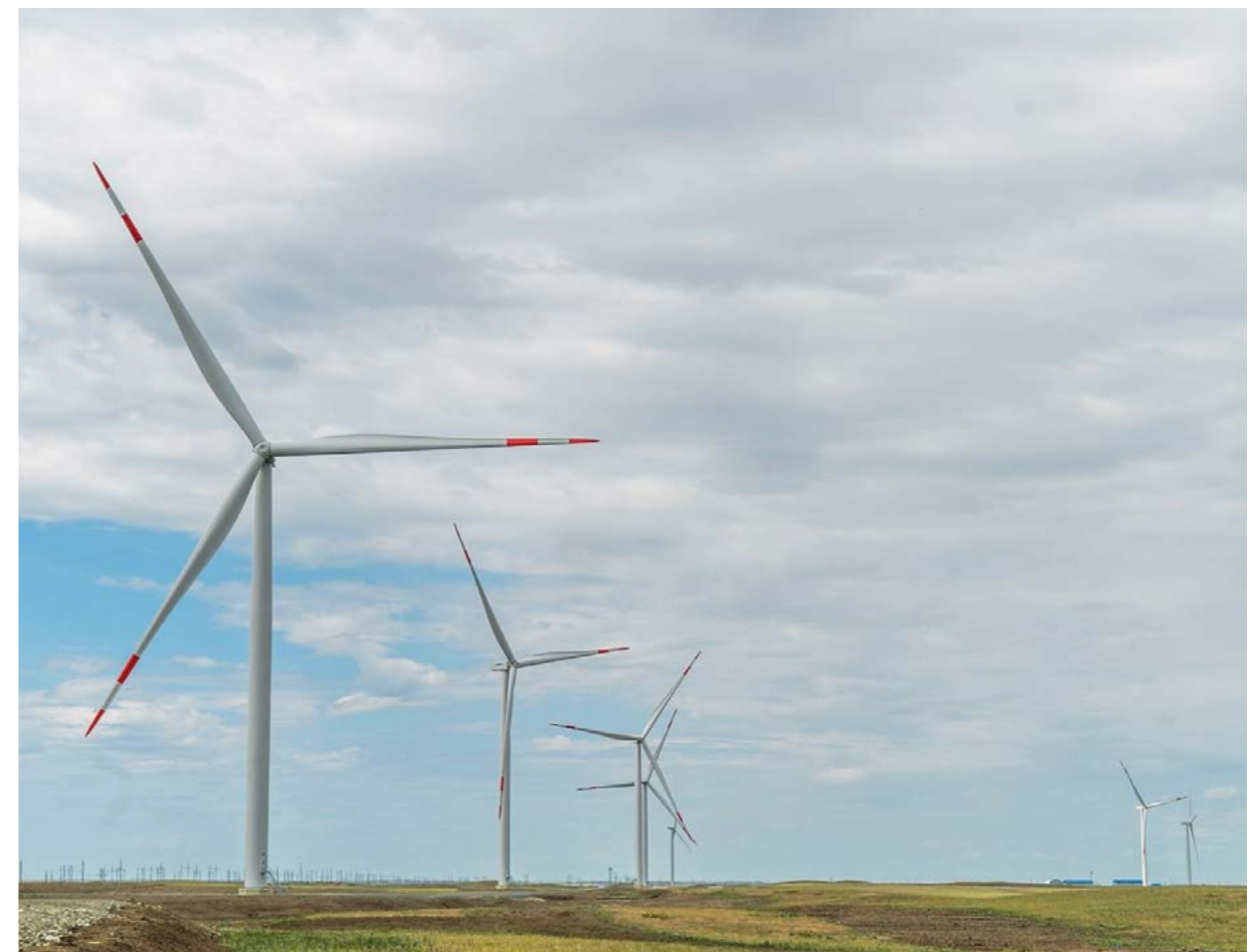
Impianto di Badamsha - Kazakistan
