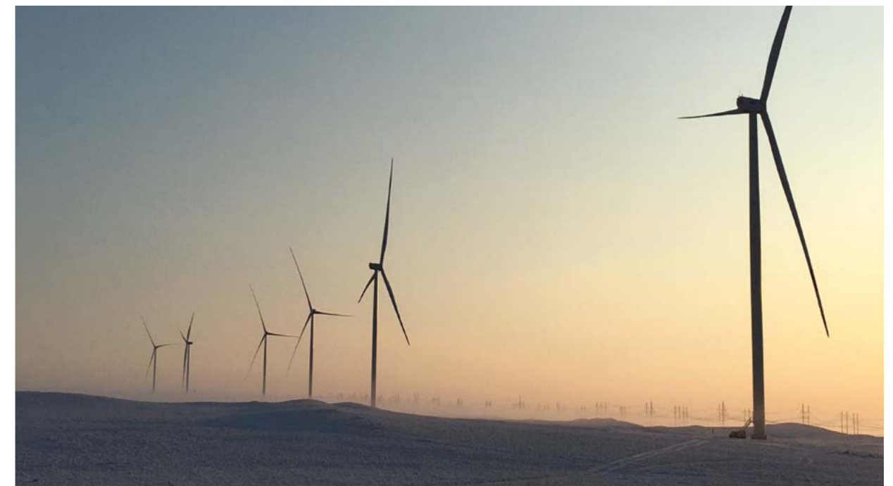
Impianto di Badamsha - Kazakistan
