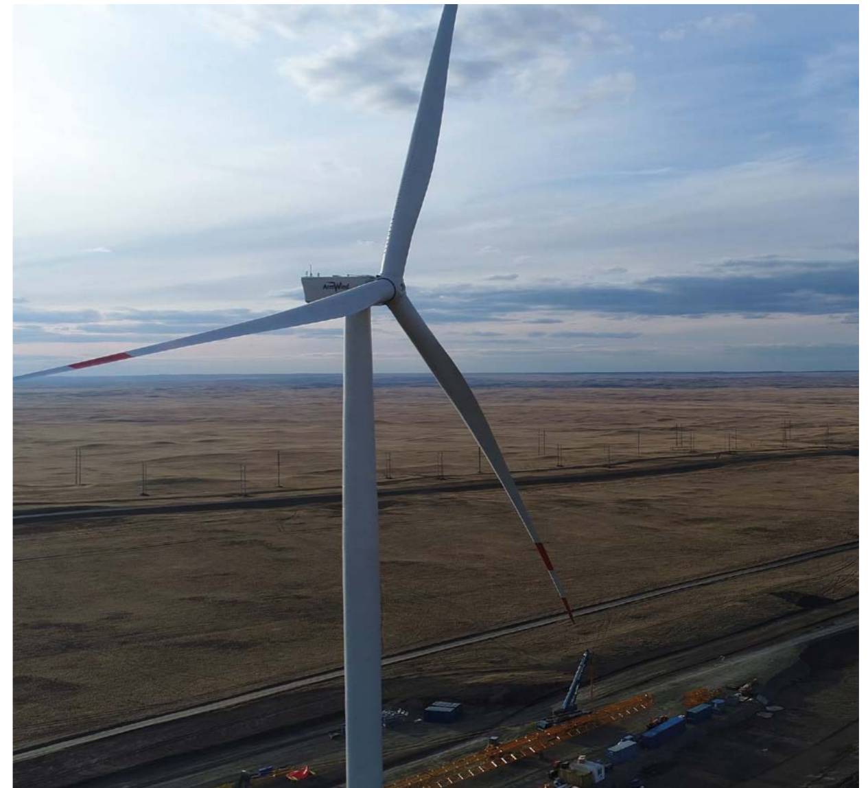
Impianto di Badamsha - Kazakistan
