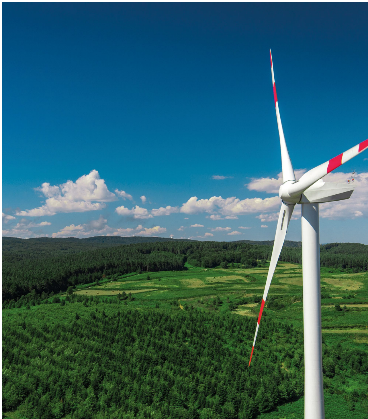
Impianto di Torre Di Ruggiero - Italia
