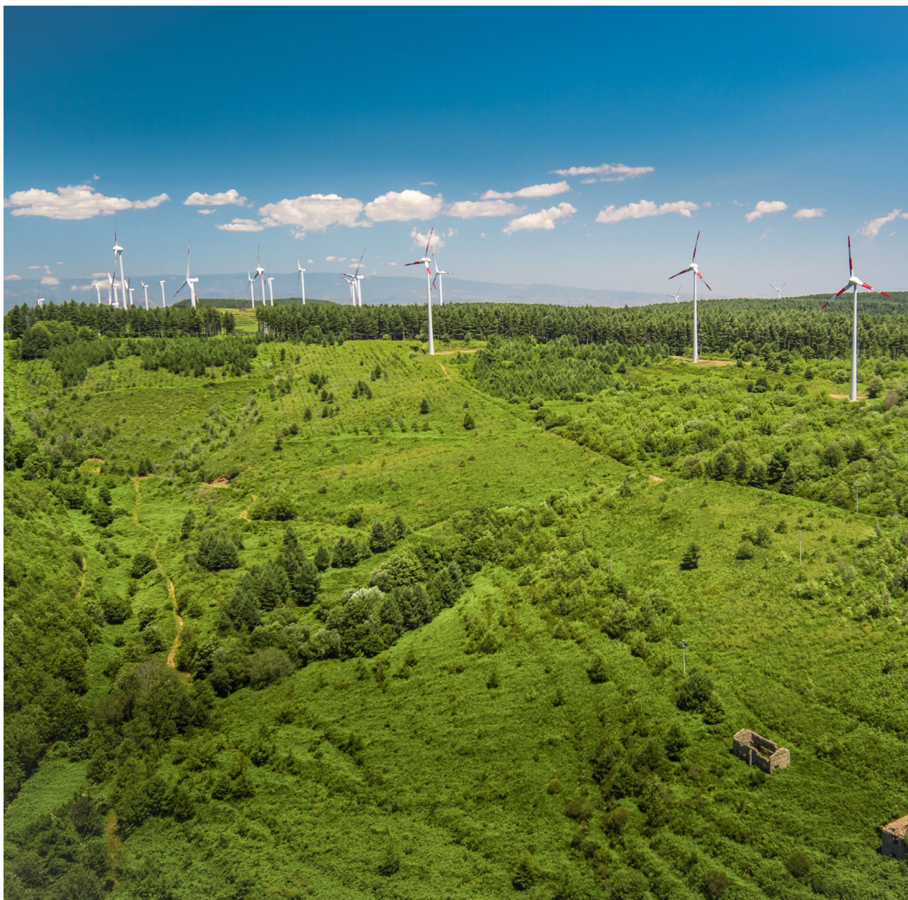
Impianto di Olivadi - Italia
