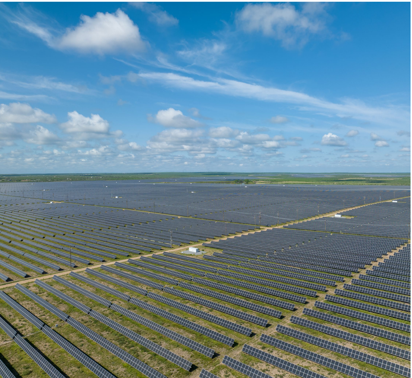
Impianto di Corazon - USA
